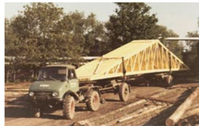
Transport einer Holzbinder-Konstruktion.
