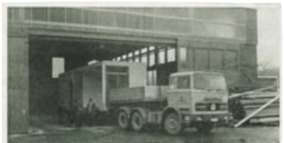
Als vierjährige Baueinheit mit Otto Baukmeier senior als Bauleiter wurde die Baueinheit nach Abschluss der Fertigung schnell schon Anfang des Jahres für den Produktionsbetrieb freigegeben. Der Fertigungsaufbau ist nach dem Vorbild der Fertigung des Kellers im Jahr 1980 für etwa 100 bis 120 Mann am Tag geplant.
