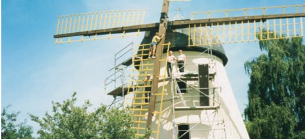
Flügelblatt-Sanierung der Tündernschen Mühle in den 80er Jahren.
