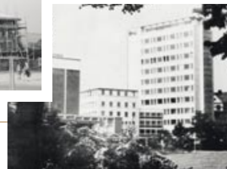
Mit handwerklicher Unterstützung der Firma Baukmeier wird bis 1954 das BHW-Gebäude am Sedan-Platz errichtet (heute: Rathaus).
